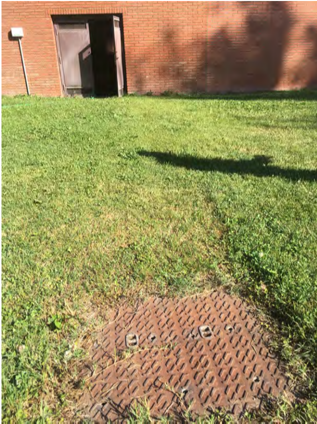
Foto 5. Canal de instalaciones hasta arqueta exterior
